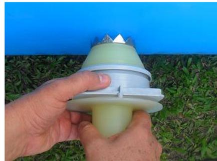
Sosteniendo la válvula por el marco gire el mango instalador en el sentido de las manecillas del reloj hasta lograr un ajuste completo.
